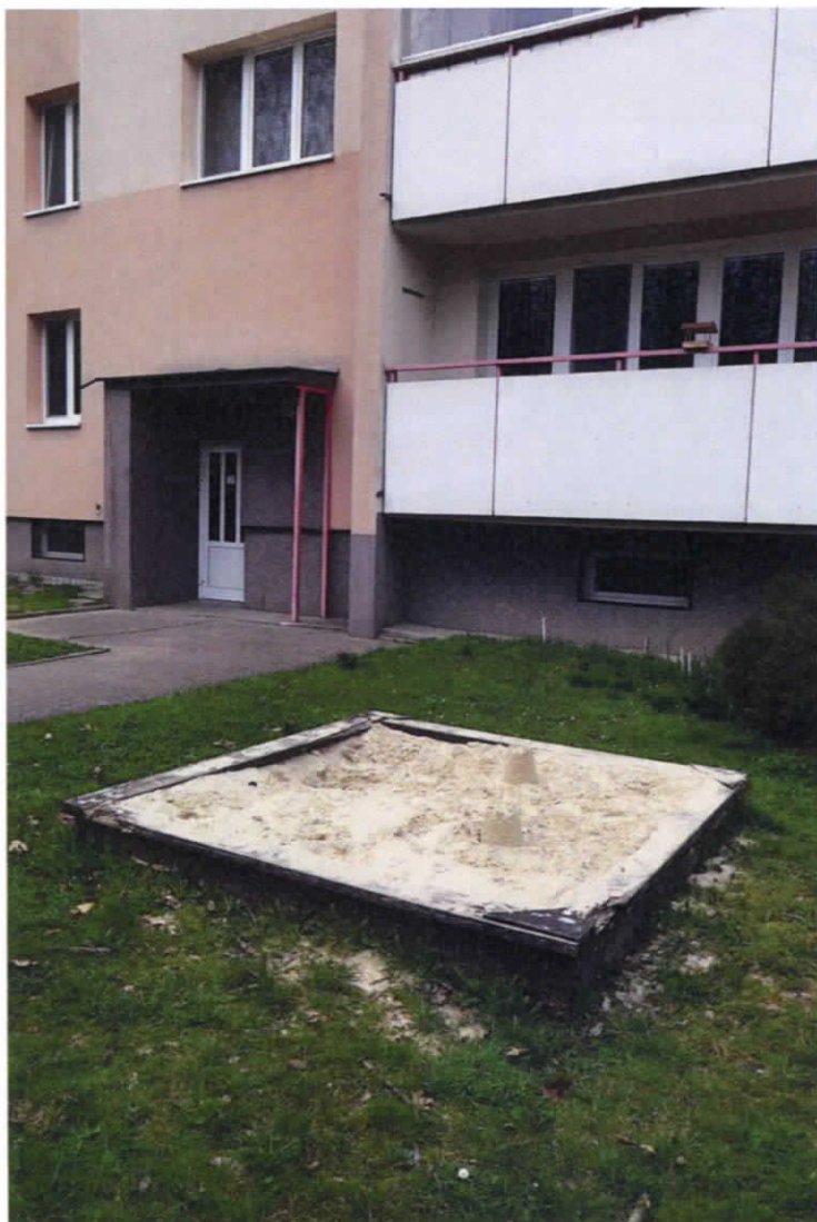
Pískoviště na ul. Slunečná – chybějící rohový díl a trčící vruty
