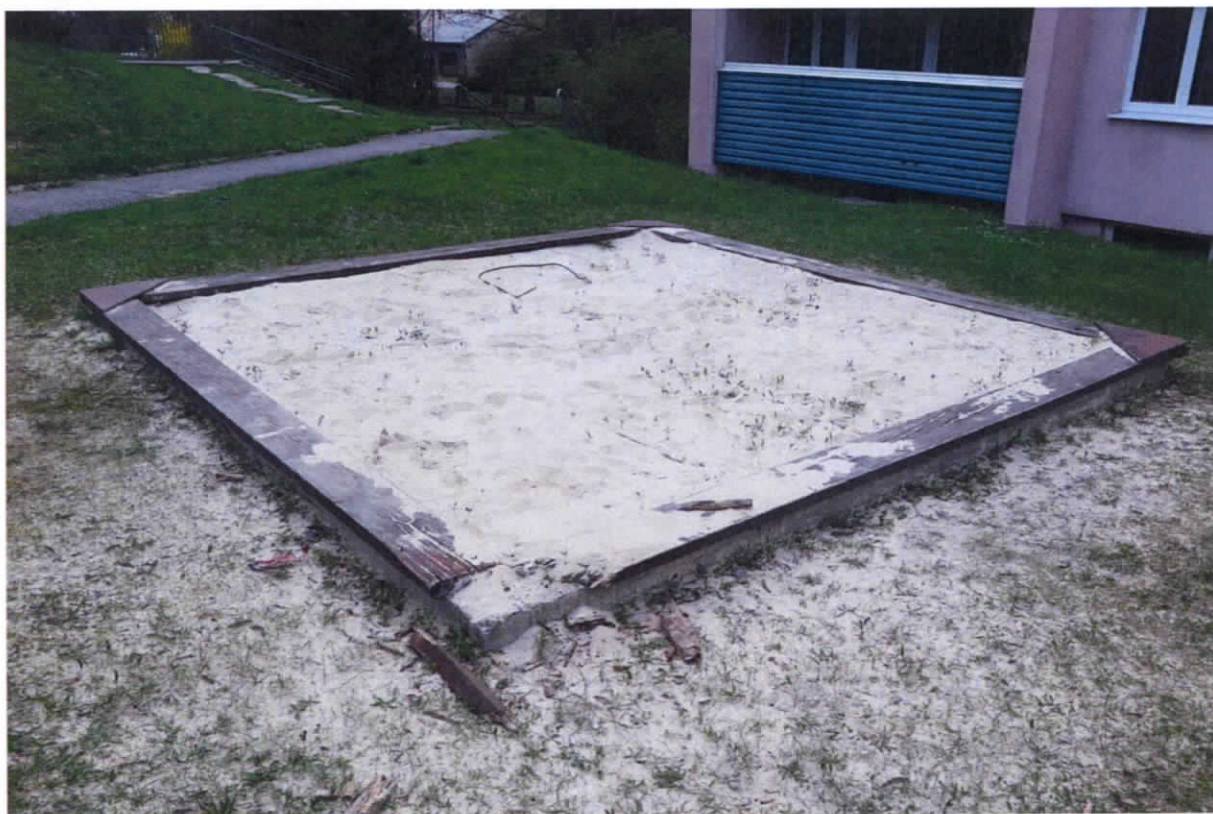
Pískoviště na ul. Karla Havlíčka Borovského – chybějící rohový díl a trčící vruty
