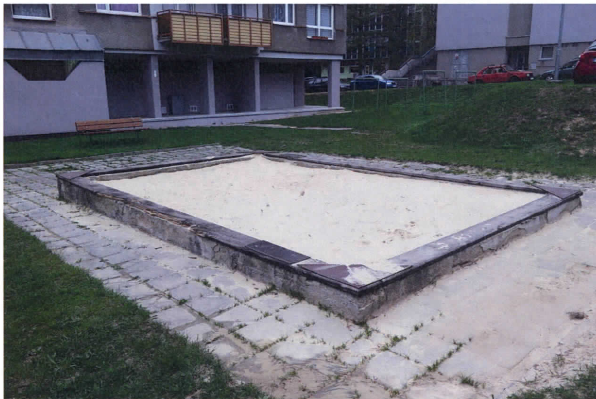
Pískoviště na ul. Kosmonautů, před vstupem do MŠ Kosmonautů – poněkud rozpadlá deska
