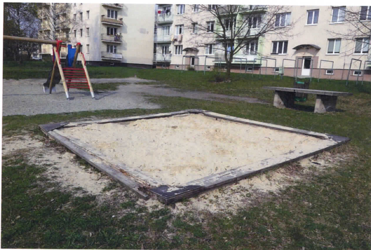
Pískoviště mezi ul. Okrajová a MŠ E. Holuba – rozpadlá deska
