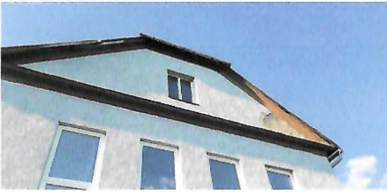
Chybějící střešní oplechování, opadávající omítka
